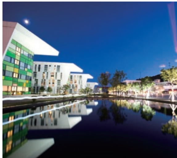
寧海電廠生活區
