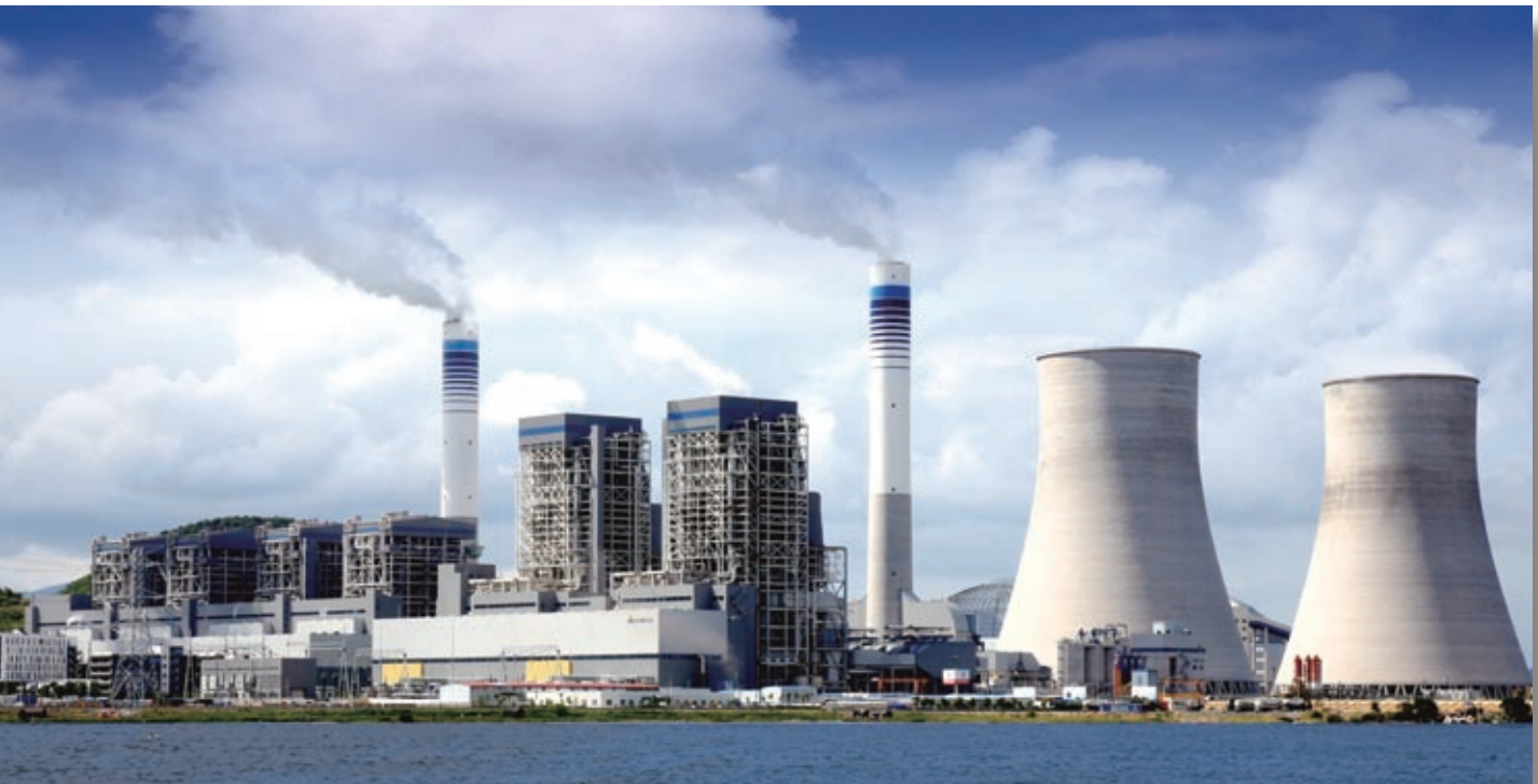
寧海電廠全景圖
